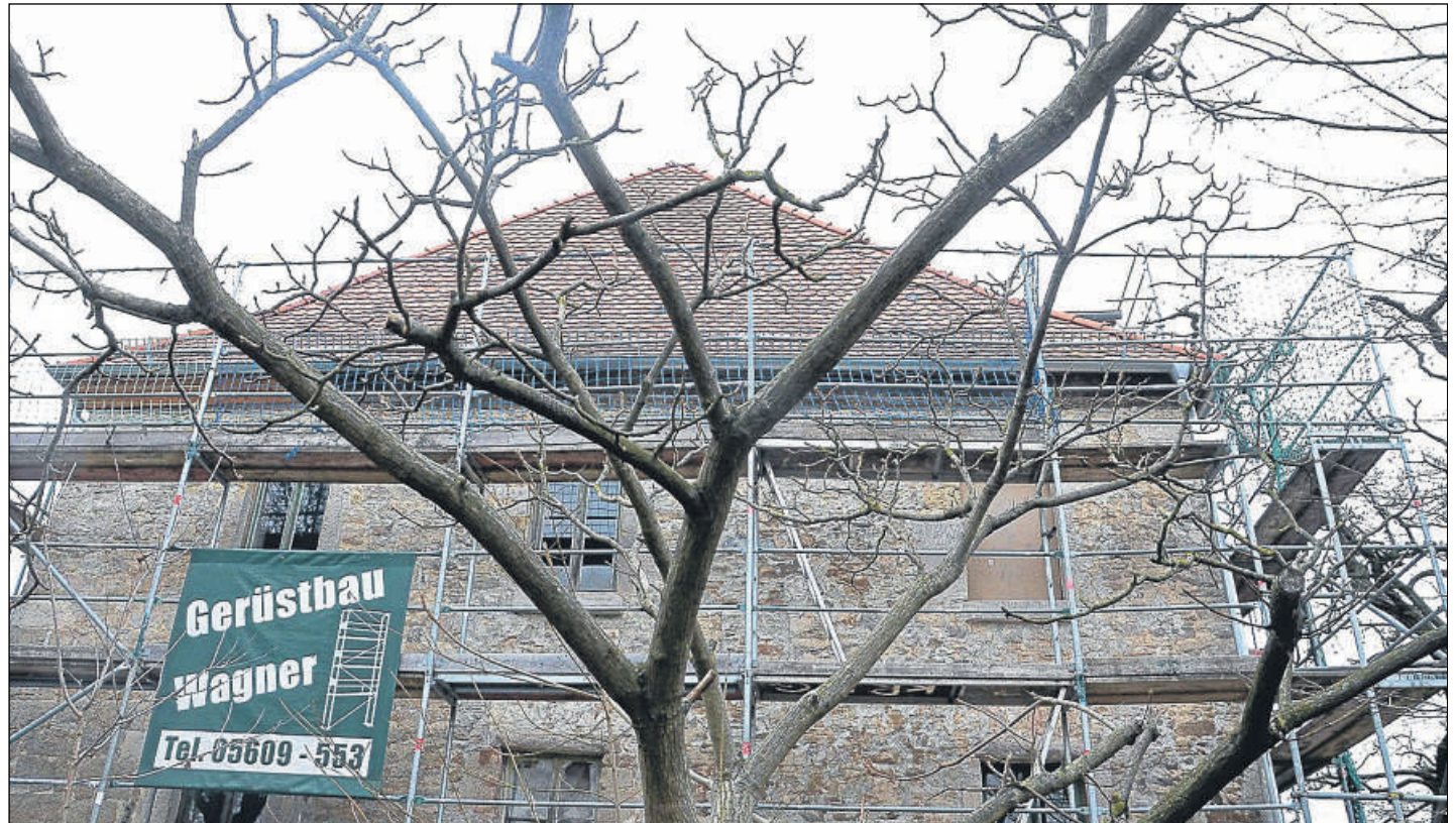
Sanierung läuft: Das Mönchshaus in Mönchshof ist eingerüstet, um die Fassade zu erneuern. Läuft alles glatt, soll das markante Bauwerk im nächsten Jahr genutzt werden können.
